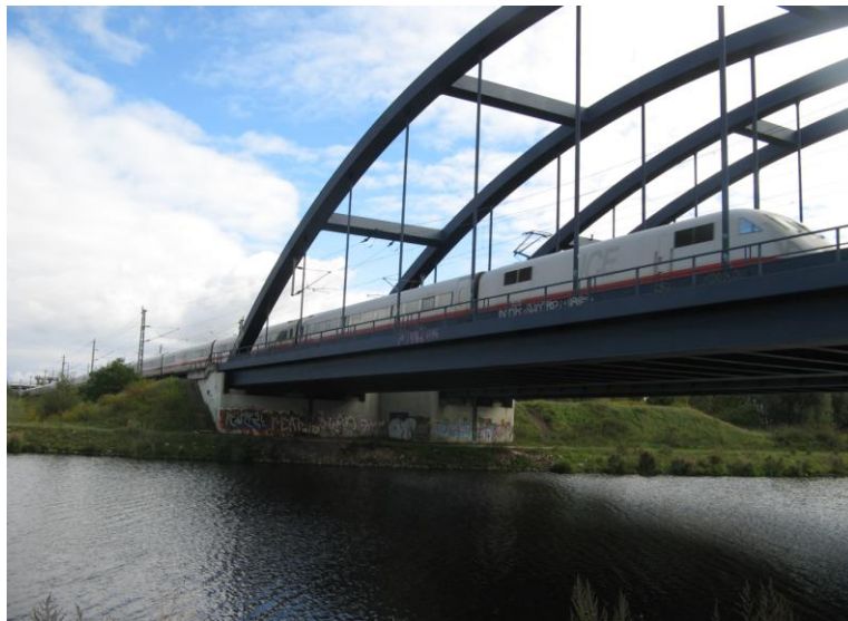
Abb. 4: Eisenbahnüberführung über den Havelkanal in Wustermark
