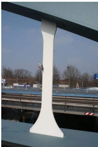
Abbildung 12: Hängeranschlusskonstruktionen - links: geschweißt (EÜ Teltowkanal Berlin), rechts: geschraubt (EÜ Berliner Straße Berlin)
