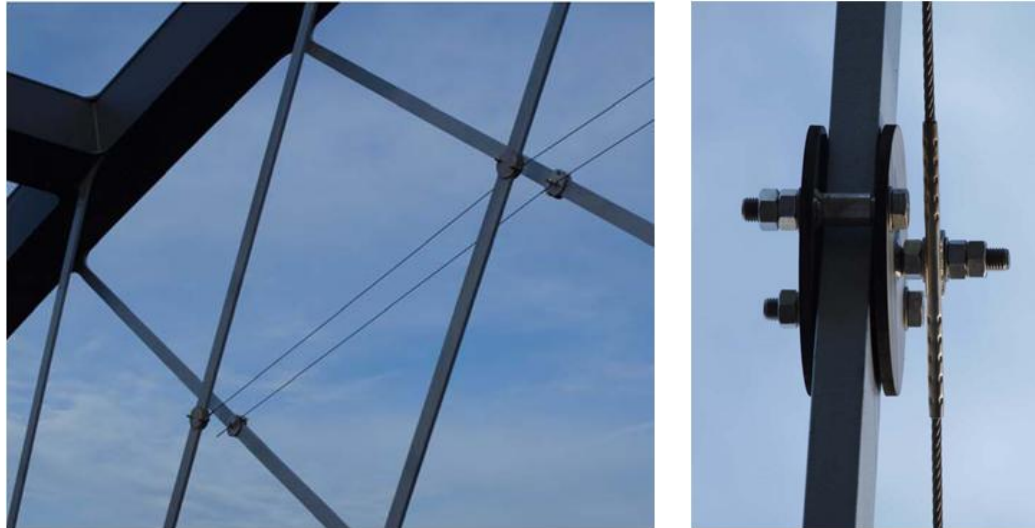
Abbildung 9: Detail der Seilverspannung an den Hängern des Netzwerkbogens EÜ Rosenbachtal
