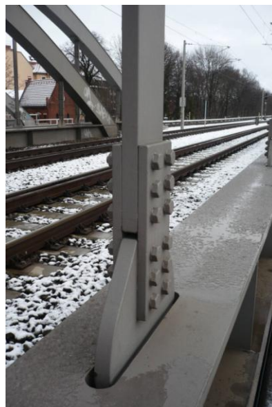
Abbildung 12: Hängeranschlusskonstruktionen - links: geschweißt (EÜ Teltowkanal Berlin), rechts: geschraubt (EÜ Berliner Straße Berlin)
