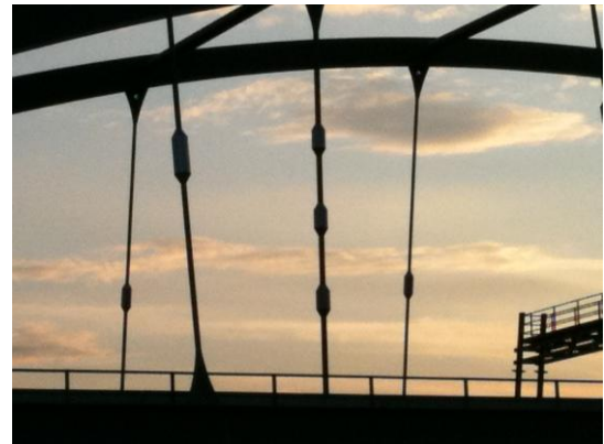
Abbildung 8: Dämpfer an den Rundstahlhängern der Brücke über den Britzer Verbindungskanal in Berlin
