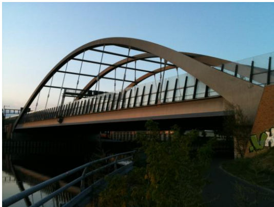
Abbildung 8: Dämpfer an den Rundstahlhängern der Brücke über den Britzer Verbindungskanal in Berlin
