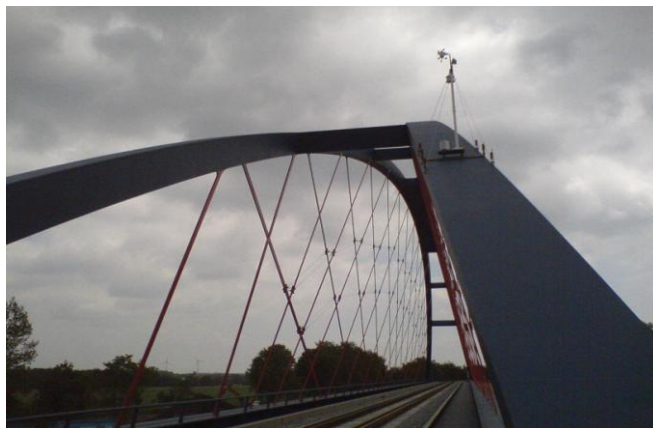
Abbildung 10: Eisenbahnbrücke über den Mittellandkanal als Netzwerkbogen (Florabrücke), die Elemente an den Hängern kennzeichnen die Führung der Seilverspannung
