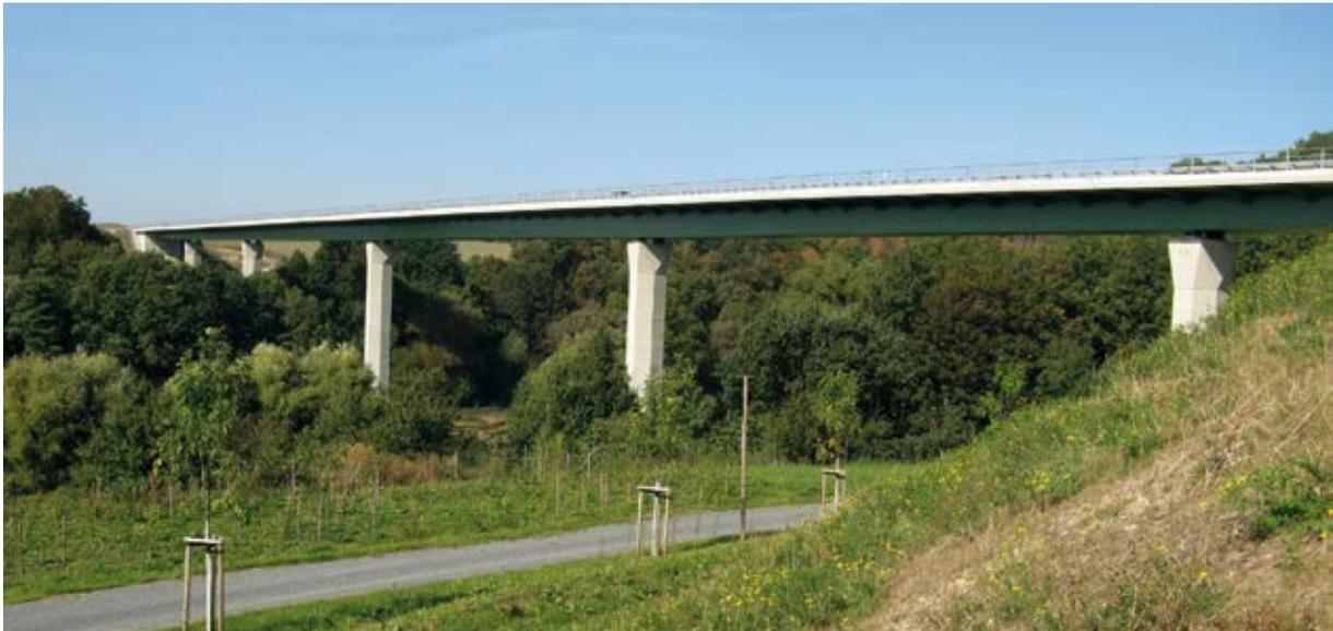
Bild 10 Ansicht der Bahretalbrücke mit Stützweiten von 36 – 52 – 72 – 76 – 64 – 52 m
