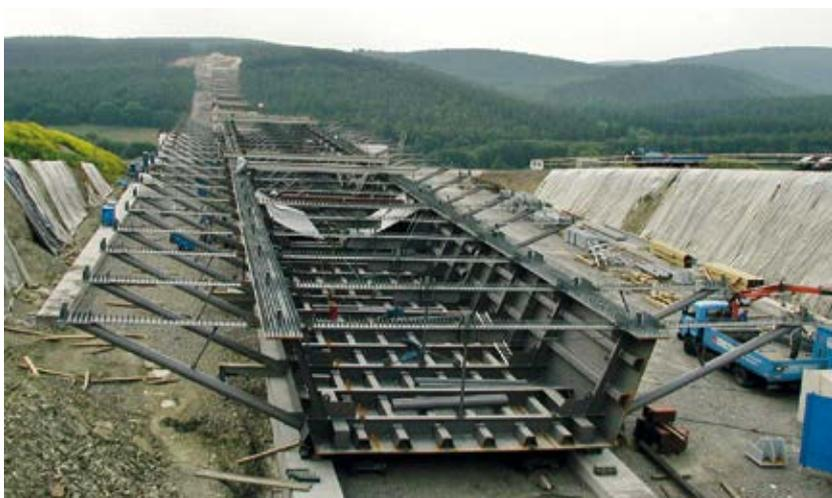
Bild 3 Einteiliger Stahlverbundquerschnitt: Reichenbachtalbrücke (A71) Foto: Gregor Gebert
