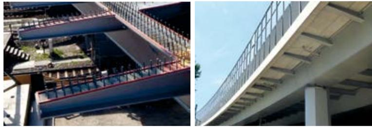
Bild 4 Langenfelder Brücke (A7) in Hamburg mit Konsolträgern und Teilfertigteilen
