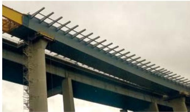
Bild 2 Typische Stahlverbund-Deckbrücken mit Teilfertigteilen: Ausführung mit Schrägstreben (Lenne-talbrücke, A45) und Ausführung mit Konsolen (Talbrücke Heidingsfeld, A3) Fotos: Gregor Gebert
