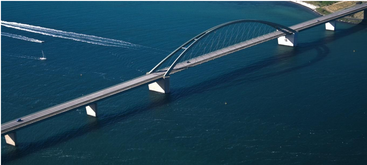
Abb. 3: Brücke über den Fehmarnsund
