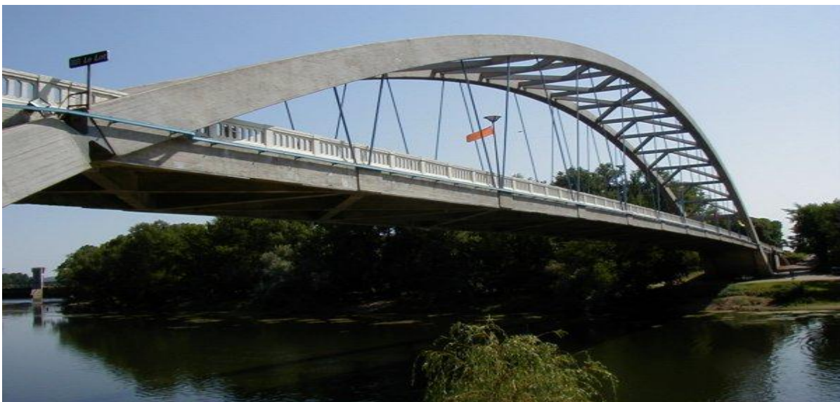
Abb. 2: Pont de Castelmoron von Nielsen, 1933
