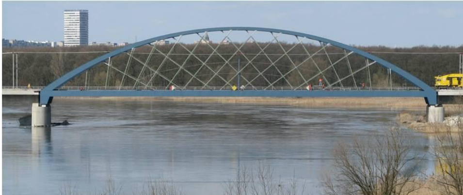
Abb. 7: Eisenbahnbrücke über die Oder in Frankfurt
