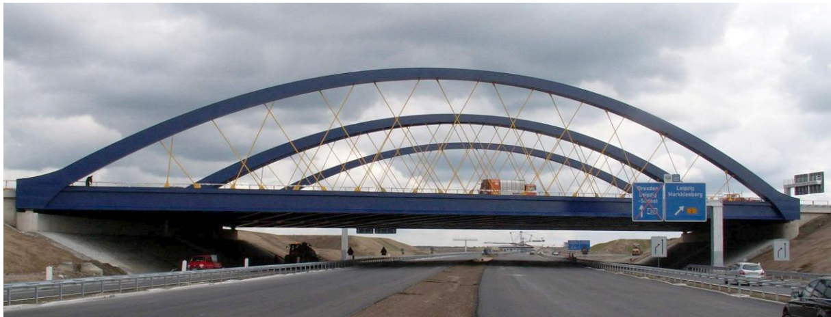
Abb. 10: Ansicht der Straßenbrücken im Zuge der B2 / 95 über die A 38
