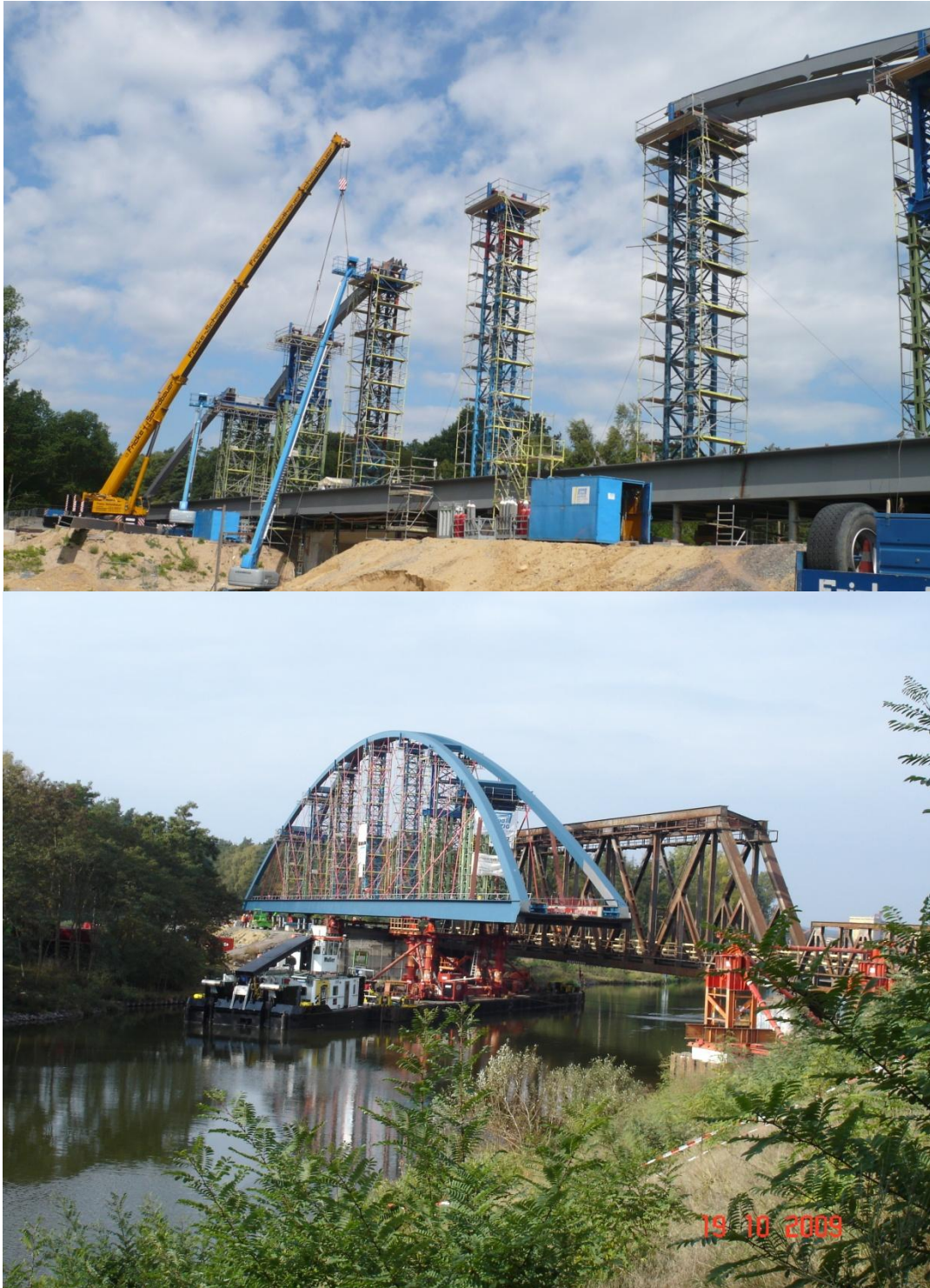
Abb. 16: Vormontage und Längverschub der Florabrücke
