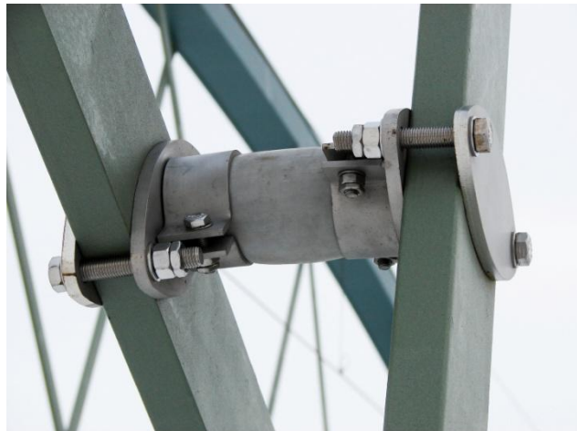
Abb. 9: Elastomerelement zur Kopplung der Hänger gegen winderregte Schwingungen
