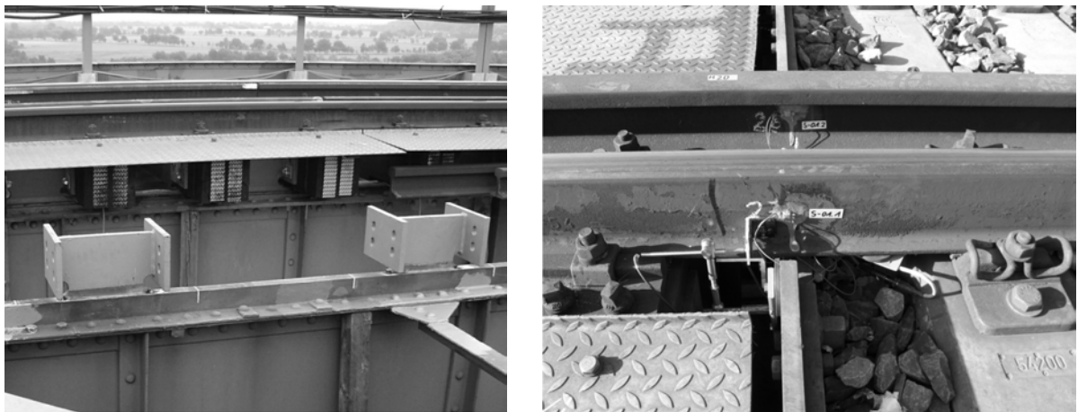
Bild 3: Messung der Dehnungen und Bewegungen der Schiene, links: Festhaltekonstruktion
