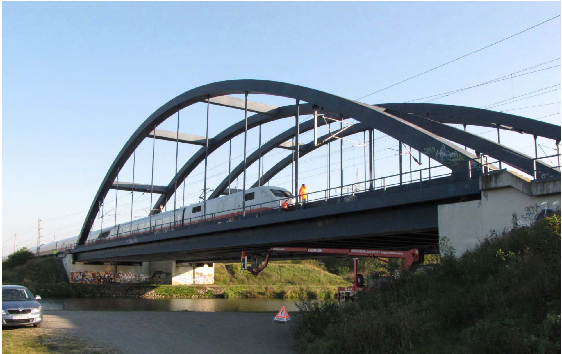
J. Rodemann, R. Stein: „Dauermessungen für dynamische Nachweise an stählernen Eisenbahnbogenbrücken“ DB Netz Zentrale, Instandhaltungsverfahren KIB (I.NPI 3(K)), Fachliche Fortbildung FvBel 02.05.2011
